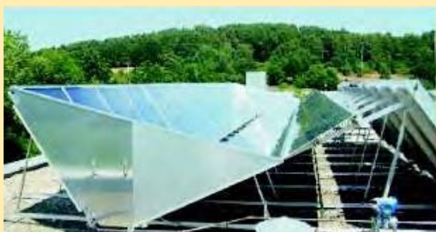
Obr. 2: Plocha s prototypy vylepšených plochých kolektorů (ve stavbě). Kolektory mají dvě krycí vrstvy (solární sklo a plastová fólie) a jsou vybaveny vnějšími reflektory.
