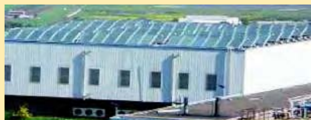
Obr. 1: Ploché kolektory na střeše výrobní haly v Montesanu na ostrově Tenerife, La Esperanza, Španělsko.
